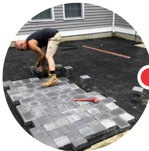
Installation de patio
