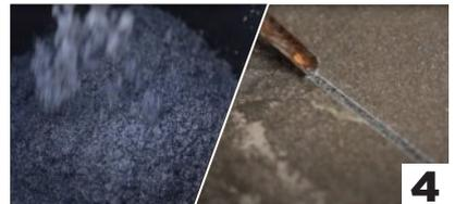
Um ein gleichmäßigeres Fugenbild zu erzeugen benutzen Sie einen entsprechenden Fugenspachtel. Dies darf erst nach der Durchführung der Schritte 1 – 4 erfolgen und erst, wenn der Nitro Sand in der Abbindefase ist. Betreten Sie die Fläche frühestens nach 18 Stunden Abbindezeit.
