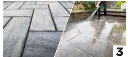
**SCHRITT 4** Jegliches überschüssige Nitro Sand-Material kann ganz einfach durch Abbürsten und Abspülen von der Oberfläche entfernt werden. Restliches Material kann auf diese Weise mit einer Wasserüberdeckung von 5 cm und im fest verschlossenen Behältnis für weitere 4 Wochen aufbewahrt werden.
