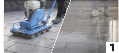
**SCHRITT 2** Öffnen Sie die Gebinde und verteilen Sie dessen Inhalt auf der gepflasterten Fläche. Bewässern Sie den Nitro Sand mit Schlauch und Duschvorsatz. Verteilen Sie den Nitro Sand mittels Schieber oder Besen in diagonaler Weise zu den Fugen. Hierdurch wird der Nitro Sand verdichtet und in die Fugen gespült und es ist sichergestellt, dass die Zwischenräume komplett verfüllt sind.
