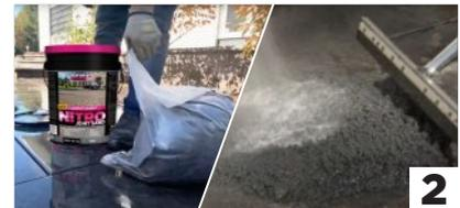
**SCHRITT 3** Die Fugen bis max. 3 mm unterhalb der Oberfläche oder 3 mm bis zur Fase mit Nitro Sand verfüllen. Die Oberfläche bewässern, um sämtliches überflüssiges Material von der gepflasterten Fläche zu entfernen. Wiederholen Sie die Schritte 2 und 3 bis die gesamte Fläche fertiggestellt ist.
